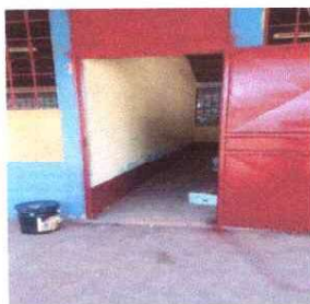
FOTO 5: Pintura en muros de exteriores e interiores
