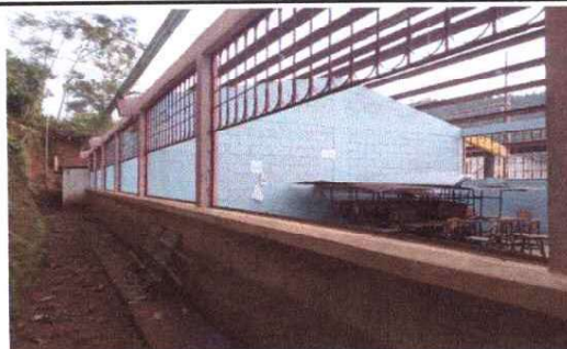
FOTO 4: mantenimiento a valcones de metal
