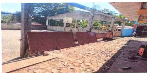
FOTO 3: Mantenimiento a estructura (lijado, cambio de tubo, cepillado, sujeciones y aplicación de pintura)
